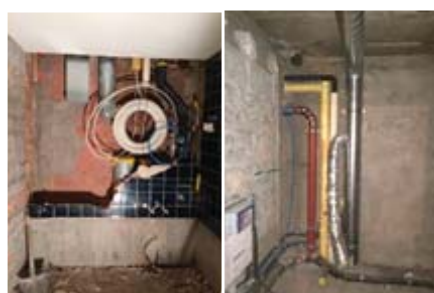
Travaux en cours
