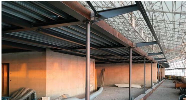
Structure sur l'attique
